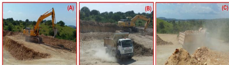
Figura 2. Proceso de extracción de caliza en la cantera. (A) Arranque; (B) Carga; (C) Transporte
