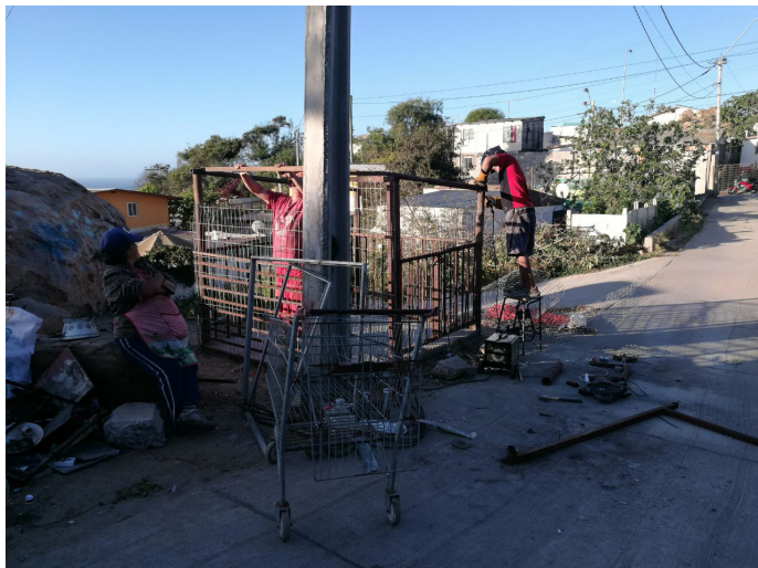
Figura 3. Construcción comunitaria de contenedores para la basura.
