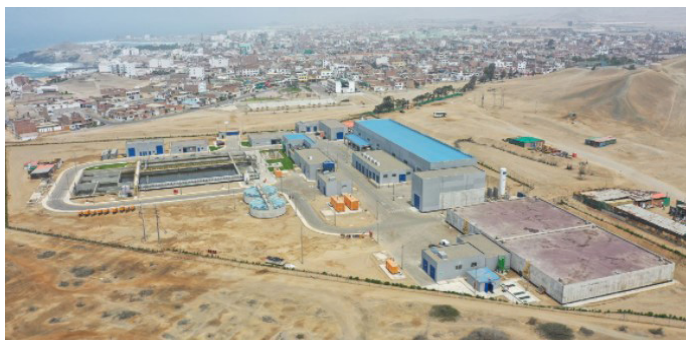
Figura 2: foto aérea da planta dessalinizadora e de tratamento de efluentes (Fernández, 2021).
