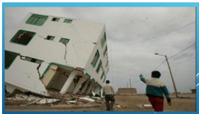
Figura 11. Derrumbe de una casa de tres pisos en Lomo de Corvina.
