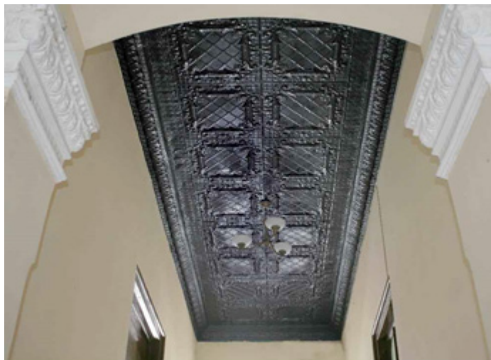
Figura 10. Falso techo de latón. Calle Luis Estévez No. 56 Santa Clara. Año de construcción: 1915.
