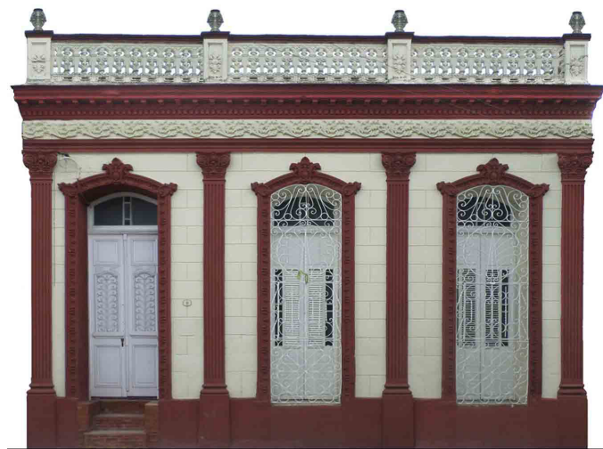
Figura 2. Fachada con ornamentación de factura popular que sobresale en el pretil, entablamento, molduras de los vanos y rejas. Ave. 9 de Abril (Este) No. 8 Santa Clara. Año de construcción 1918.
