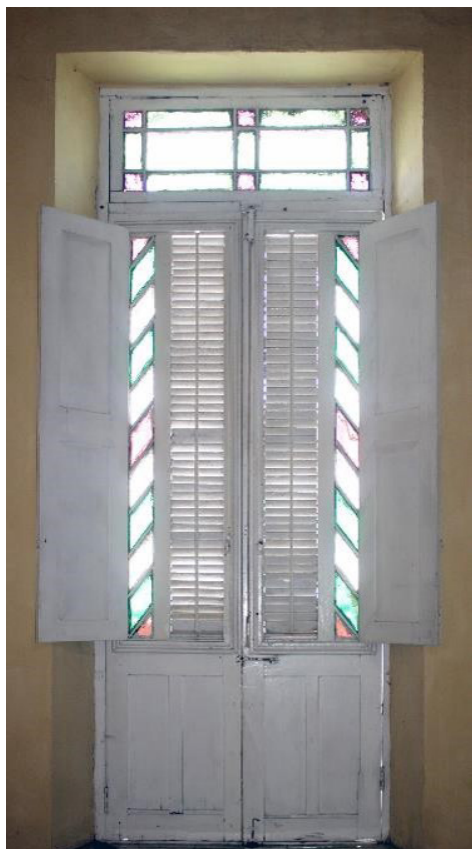
Figura 5. Ventana exterior. Ave. 9 de Abril (Oeste) No. 53 Santa Clara. Año de construcción 1912.
