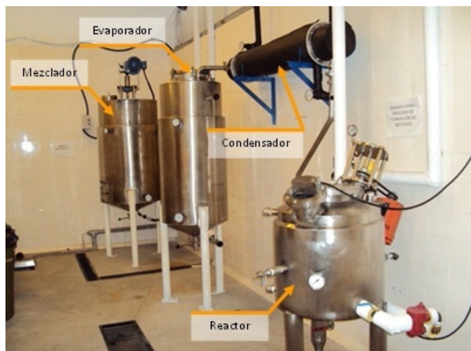
Figura 2. Planta piloto de obtención de biodiesel de biomasa residual instalada en la Universidad de San Carlos de Guatemala, Guatemala.
