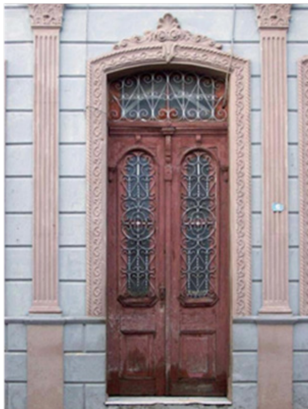
Figura 4. Puerta principal. Calle Martí (Oeste) No. 6 Santa Clara. Año de construcción 1920.
