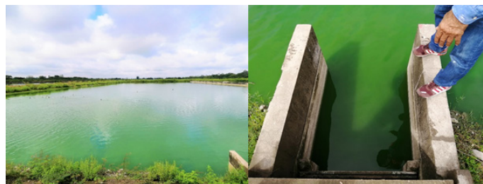
Figura 5. Piscinas de maduración del sistema de tratamiento de aguas residuales de San Francisco de Milagro.
