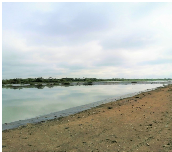
Figura 4. Piscina de fermentación del sistema de tratamiento del STAR.
