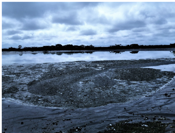
Figura 3. Piscina anaeróbica del STAR.
