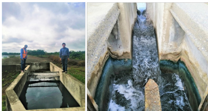
Figura 2. Ingreso del efluente a las piscinas anaeróbicas del STAR.
