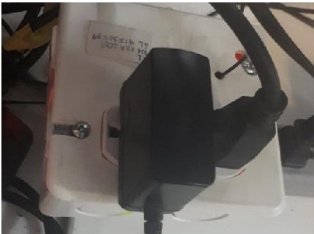
Figura 11. Nodo Router 2 Recopilando Datos.
